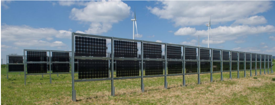
Abbildung 5-8: Bifaziale Module - Modellanlage Next2Sun
