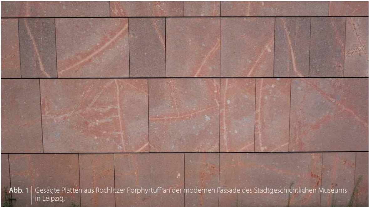
Abb. 1 | Gesägte Platten aus Rochlitzer Porphyrtuff an der modernen Fassade des Stadtgeschichtlichen Museums in Leipzig.
